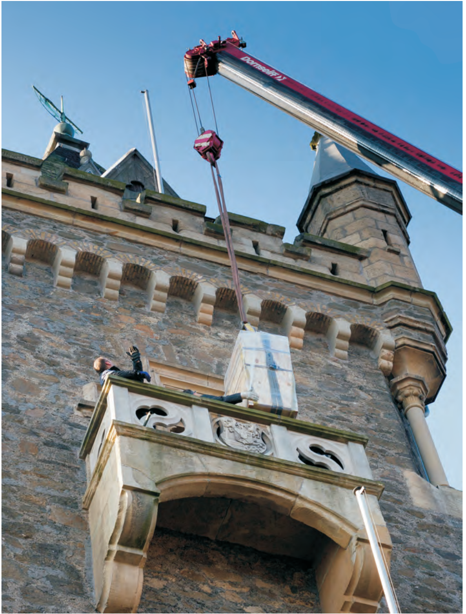
Die Büste von Johann Moritz wird mittels Kran in den Wilhelmsturm gehoben.
